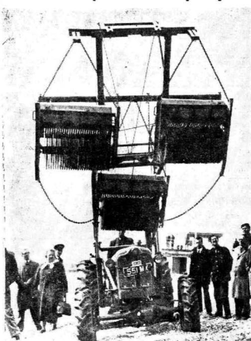
Este extraño apero izado por un tractor tiene su aplicación en la limpieza de las playas, para dejar prendidos en sus ruedas dentadas los residuos de alquitrán de los barcos que la marea deposita en la arena...
